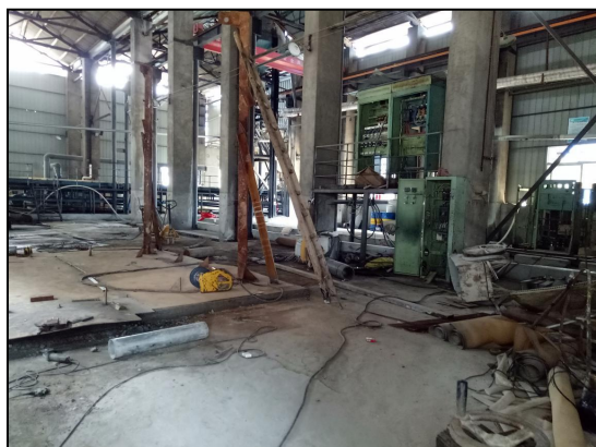
浮选车间设备拆除后现场
