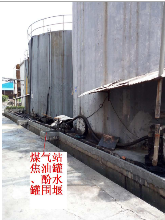
焦油罐、酚水罐围堰
