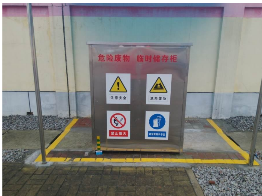
图 3-11 危险固废临时暂存柜示意图
