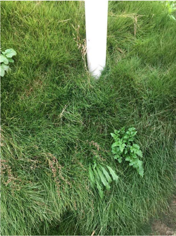
PVC 管掩埋后的照片 2
