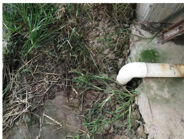
PVC 管掩埋后的照片 1
