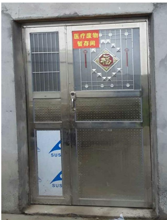
医疗废物暂存间
