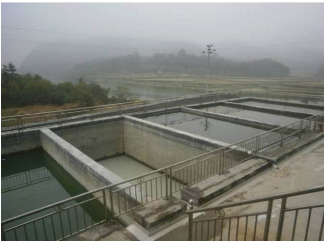
初期雨水收集池及沉淀池
