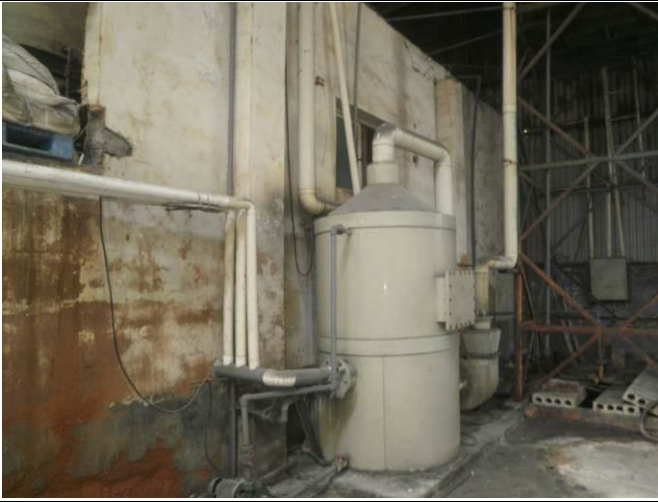
(7#) 萃取二车间酸雾废气处理系统
