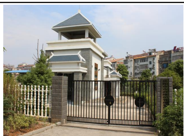
理工学院提升泵站
