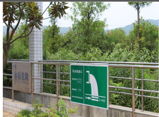
污水处理厂废水排放口
