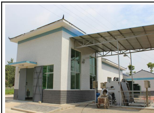
郭镇提升泵站
