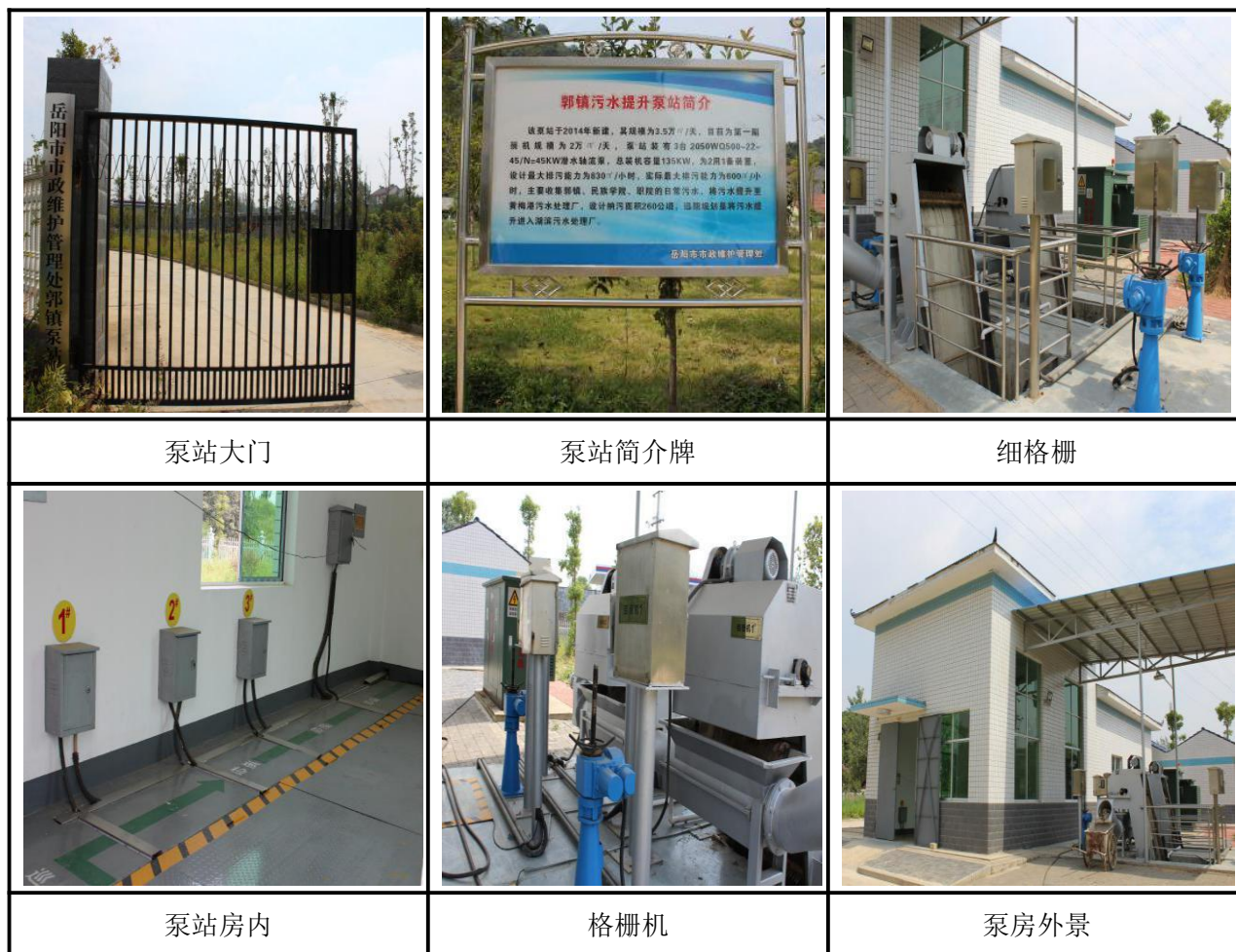
图 3-4 郭镇污水提升泵站
