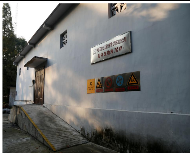
危废暂存库外部
