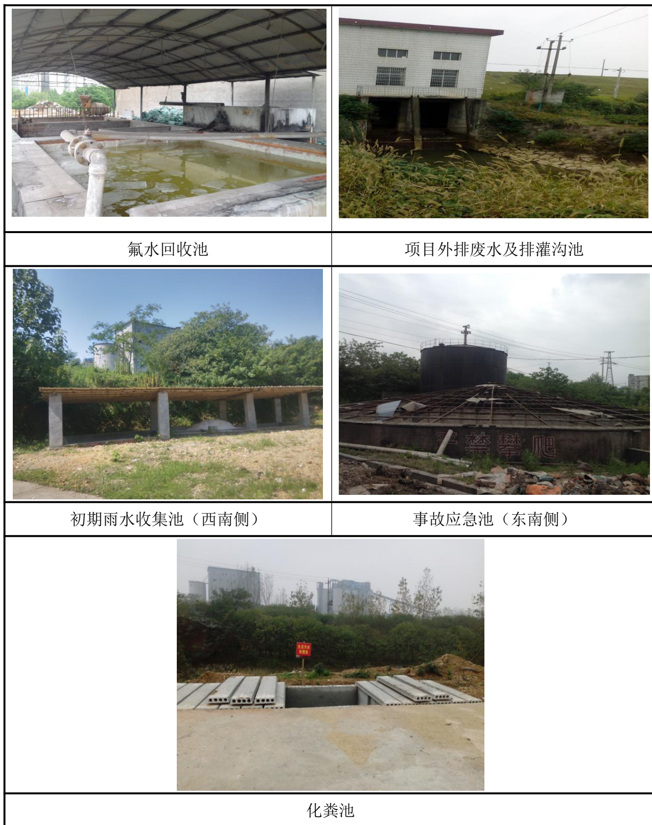
图 3-6 项目部分废水处置设施
