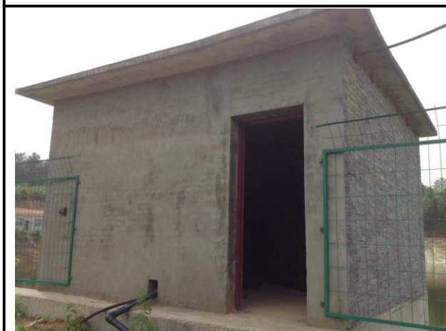
抽排渗滤液机泵房
