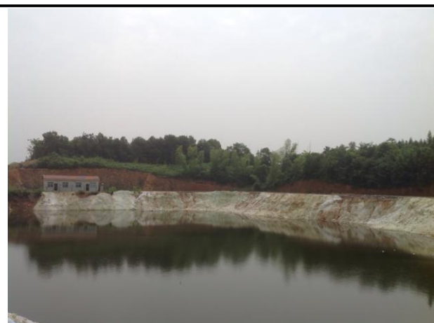
渗滤液收集池
