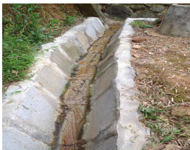
场区北面（垃圾坝下方）雨水沟
