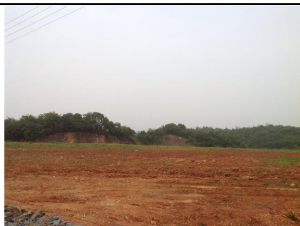
三期（已完成覆土，正在种植绿化）
