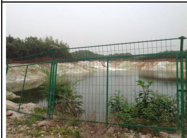
渗滤液收集池
