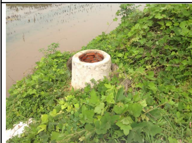
居民处 3 号监测井
