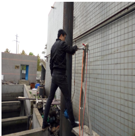
8t 锅炉采样点
