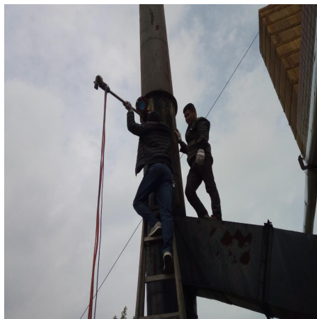
4t 锅炉采样点
