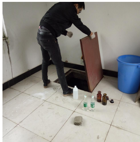
污水处理站总排口
