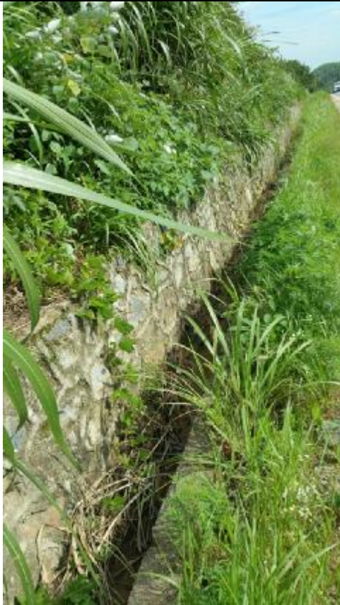
公路两侧边坡防护及排水设施
