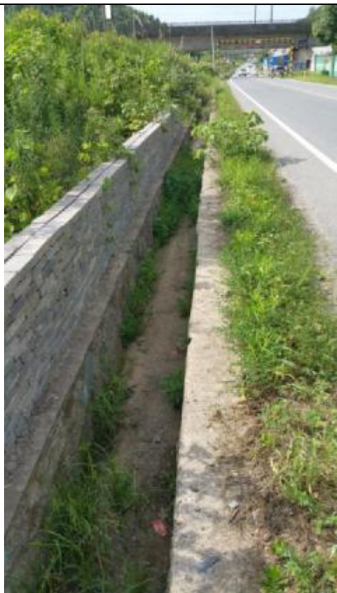
公路两侧排水设施（明沟）
