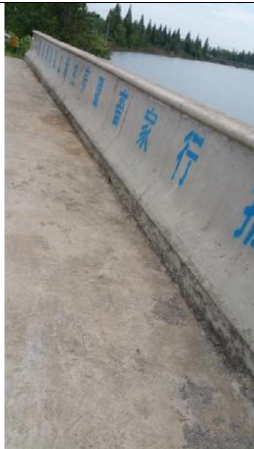
桥梁两侧防撞防护
