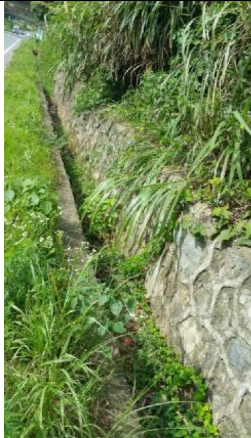
公路两侧边坡防护及排水设施
