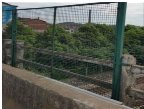
上跨京广铁路桥梁防护
