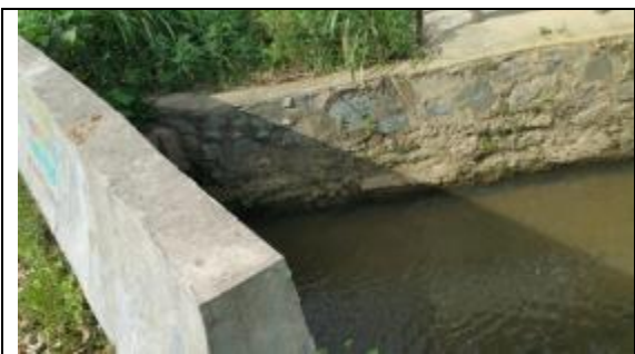
桥梁两端边坡防护
