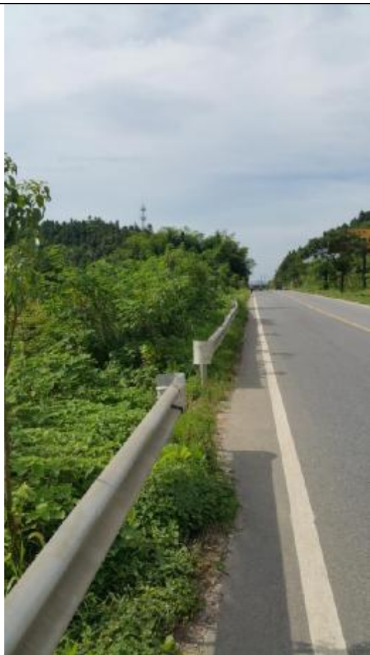
道路两侧护栏防护
