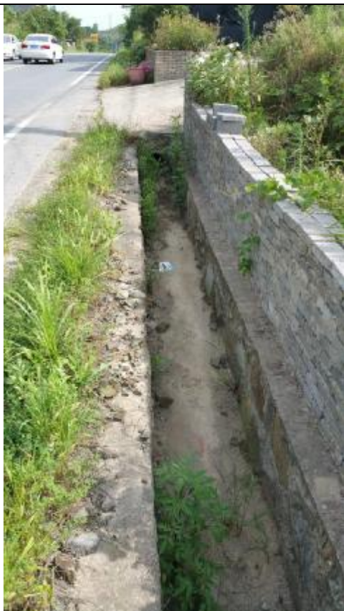
公路两侧排水设施（明沟）
