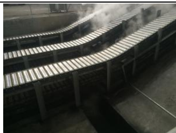
铸锭生产线冷却过程
