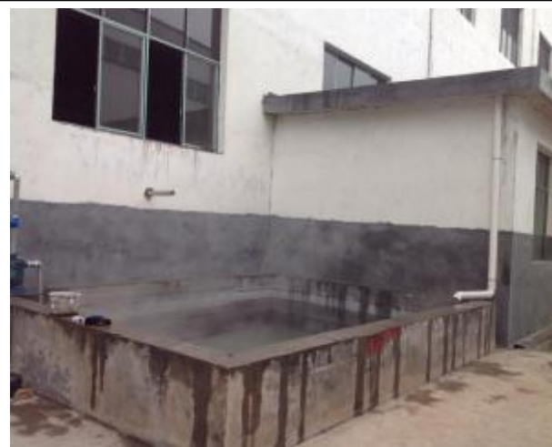
铸锭冷却水收集池
