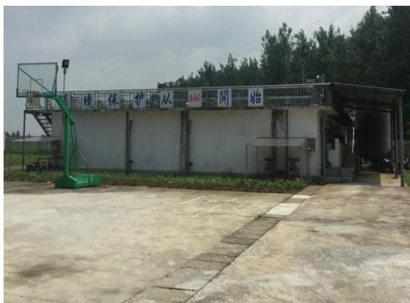
污水处理站全貌
