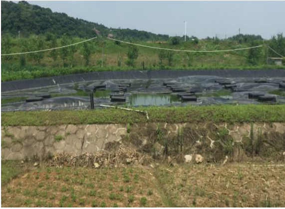
渗滤液调节池
