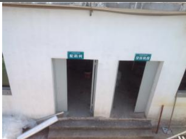
污水处理站配药间、空压机房
