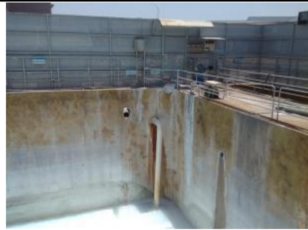
生产废水进入调节池
