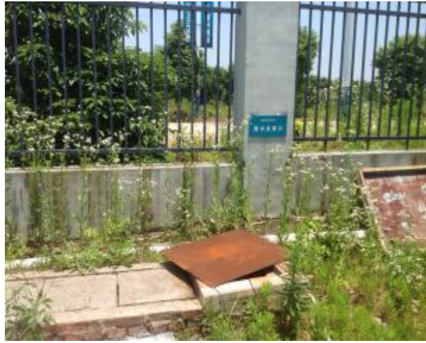
生产废水排放口
