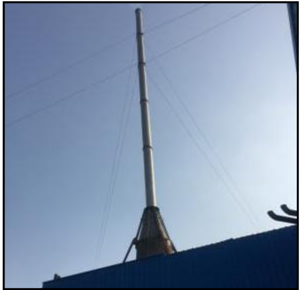
锅炉房排气筒（45m）
