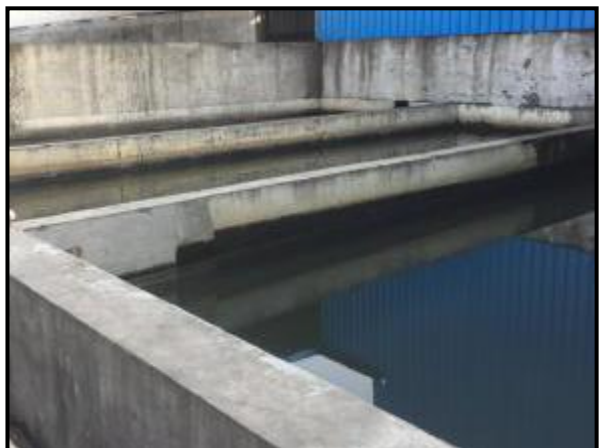
除尘废水循环池
