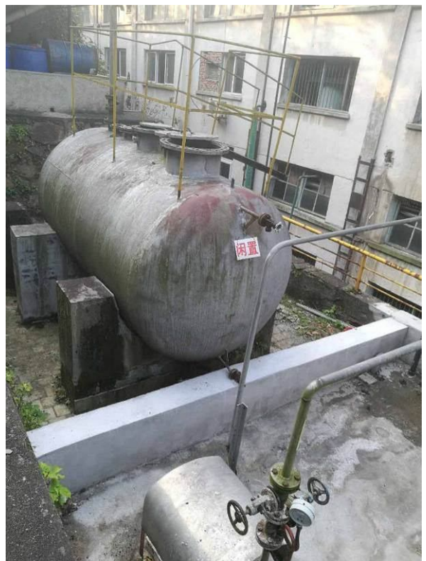
闲置罐区（挂牌）
