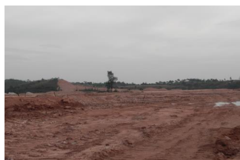
项目南侧山林
