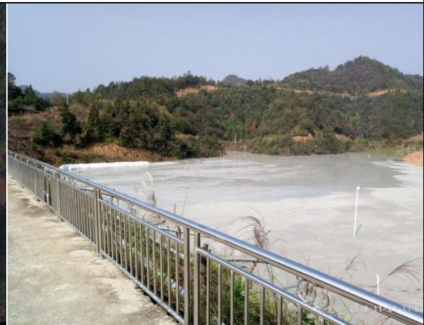
石坪尾矿库现状
