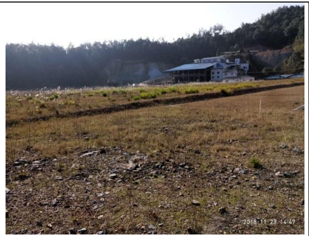
正垅坡尾矿库已完成闭库 生态恢复良好
