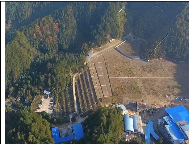
正垅坡尾矿库已完成闭库现状
