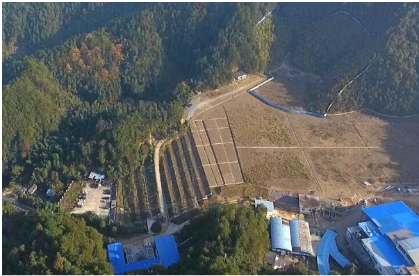
尾矿库已完成闭库现状
