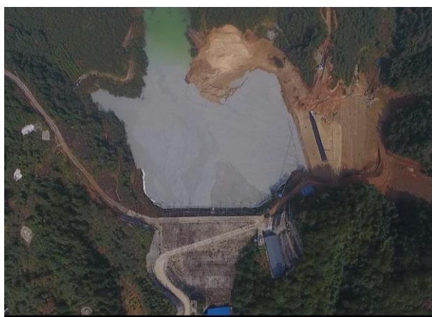
石坪尾矿库现状
