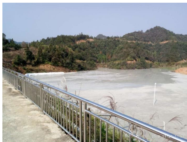
石坪尾矿库现状
