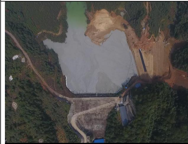
石坪尾矿库现状
