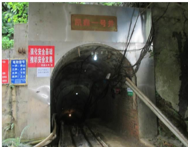
采矿工业广场主斜井
