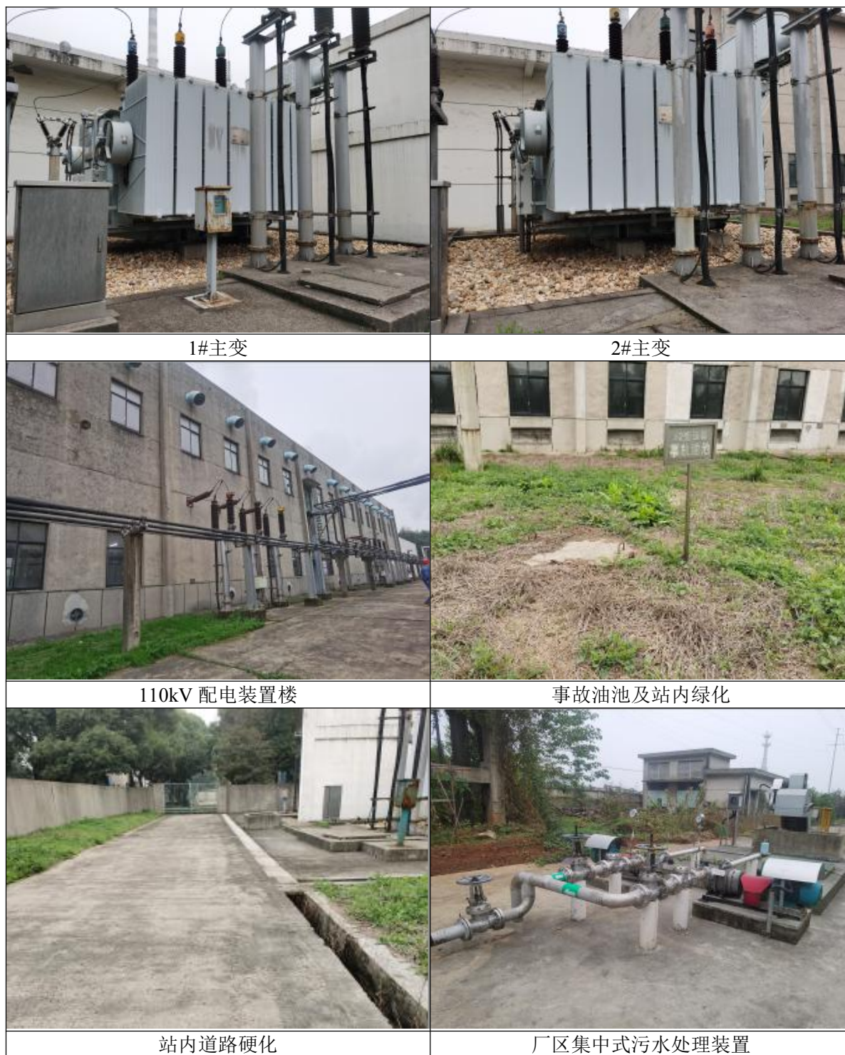
图 1-1 变电站已建工程现状照片
