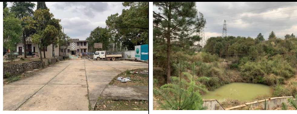
图 3-2 笔架山 110kV 变电站周边环境现状图（依次为东、南、西、北侧）
