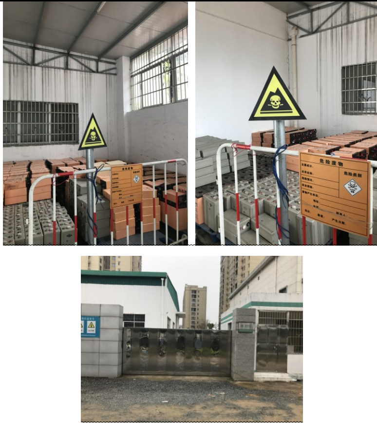
图4-8 国网岳阳供电公司云溪仓库
