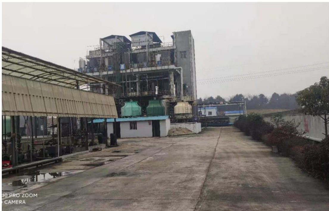
图 5.3-4 项目场地硬化及绿化带现状照片
