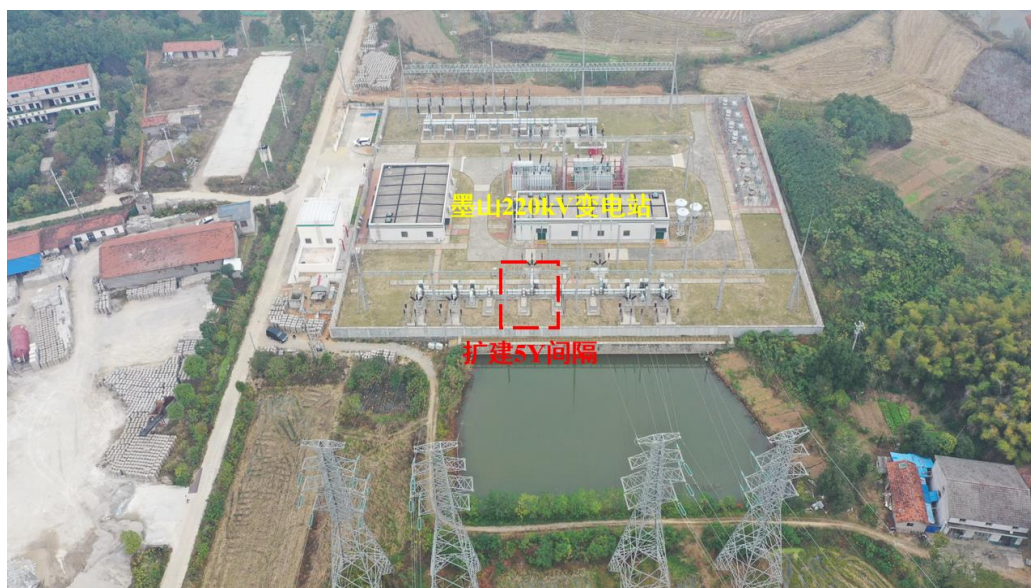
图 2-1 墨山 220kV 变电站间隔扩建
