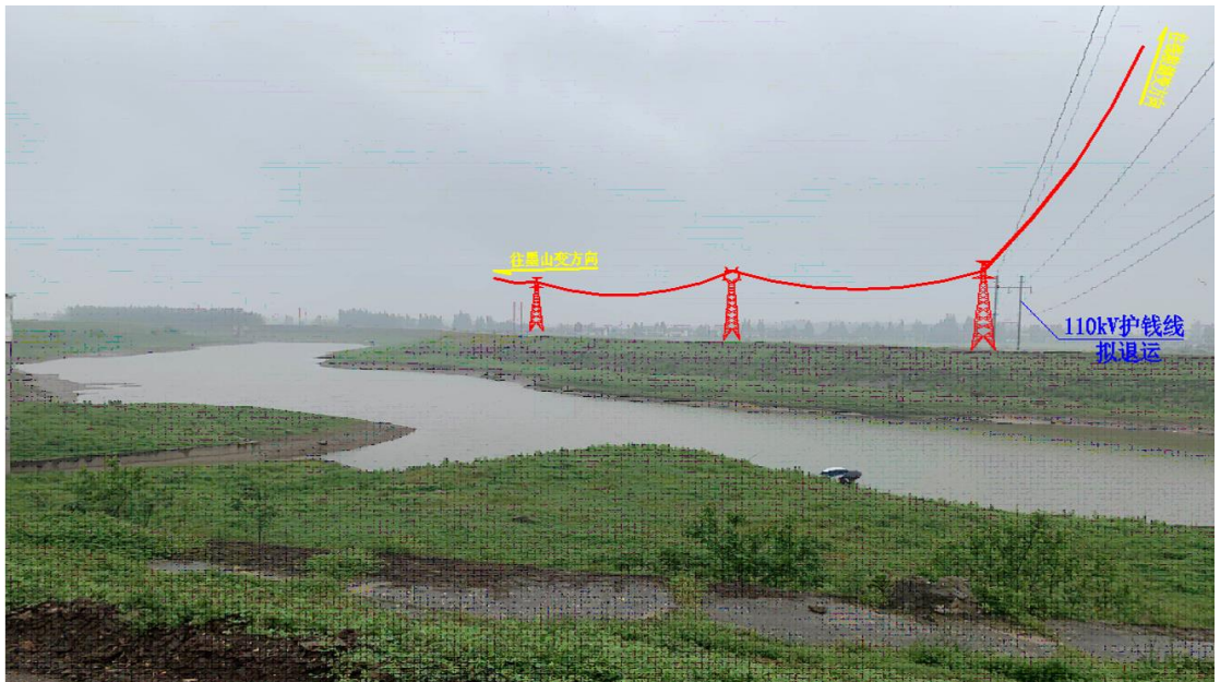
图 3-4 输电线路沿线现状（跨越华容河）
