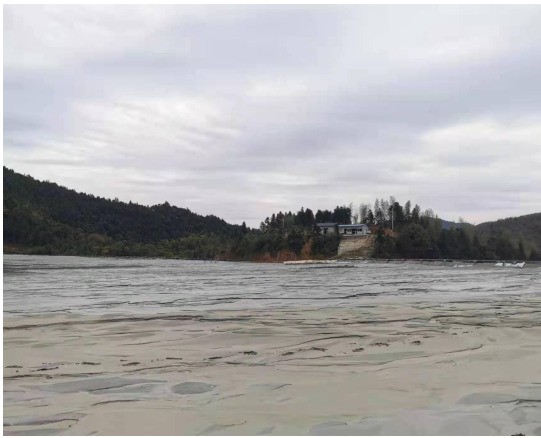
高流坑尾矿库
