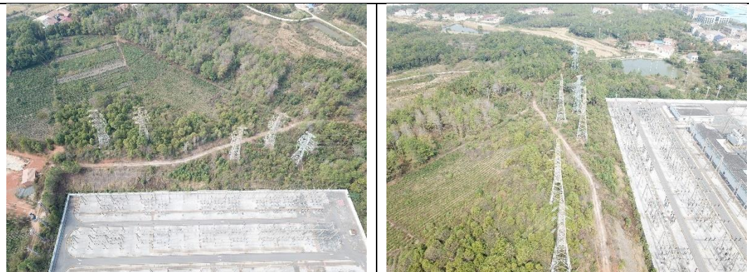
文里 220kV 变电站 110kV 间隔侧厂界
