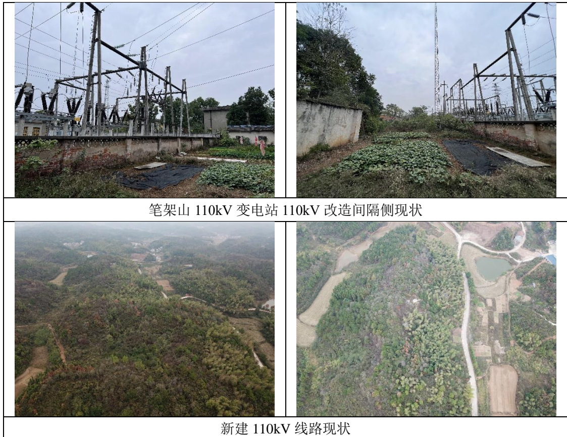
图 3 湖南岳阳临湘峡山-兆邦 II 回 T 接笔架山变 110kV 线路工程环境现状
