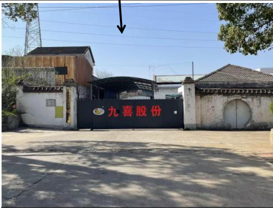
项目西厂界（湖南省九喜日化有限公司）
