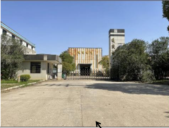
项目北厂界（汨罗市通变电气有限公司）
