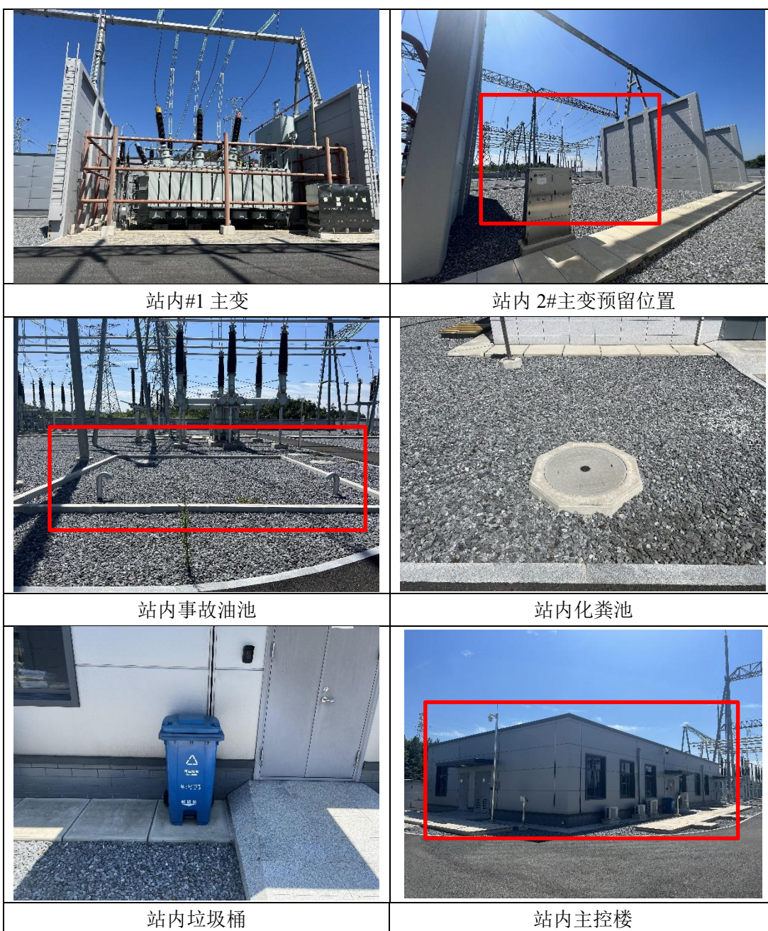
图 1 画桥 220kV 变电站站内环境现状
