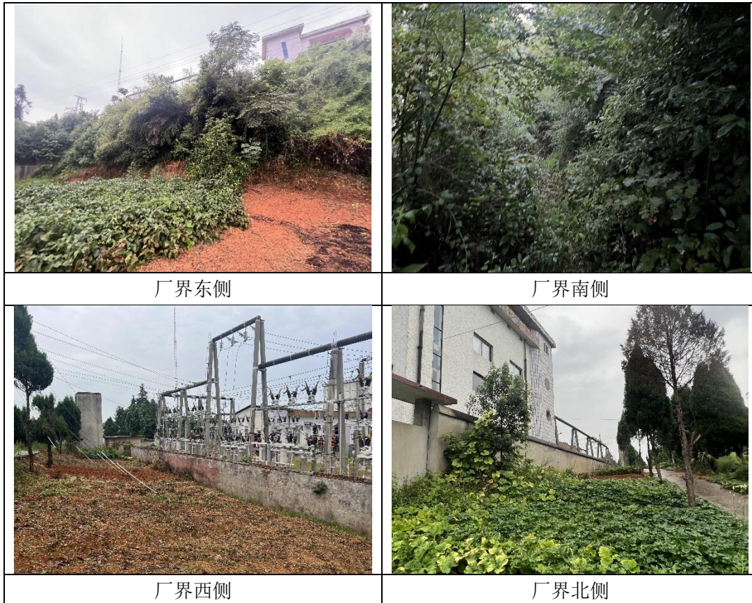
图 6 源潭 110kV 变电站区域自然环境现状
