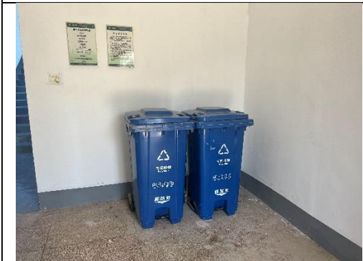
站内生活垃圾收集设施
