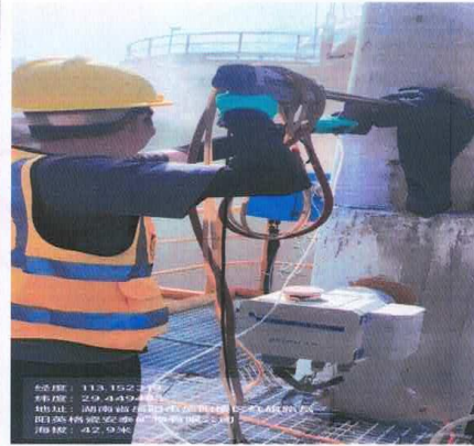
DA002 碳化罐排放口 1
