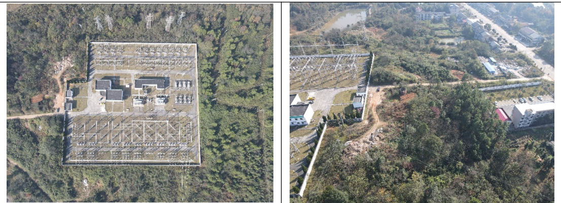
袁家铺 220kV 变电站周围环境
