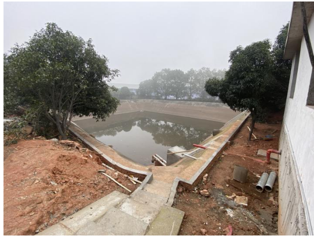
项目东侧消防水池
